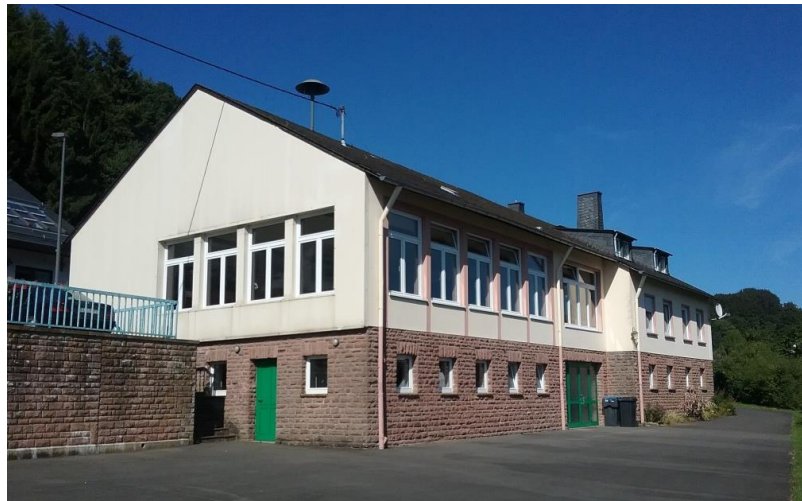
Blick auf das Dorfgemeinschaftshaus
