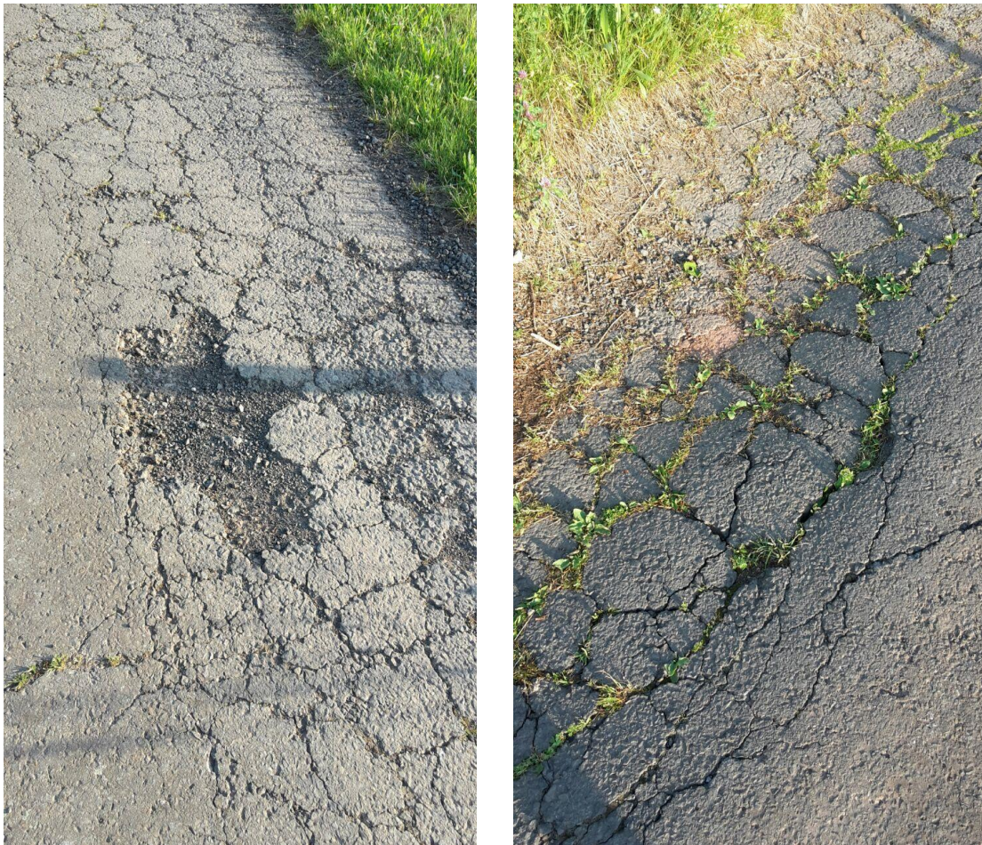
Wirtschaftswege im Bereich Wohnplatz Neuenweiher
