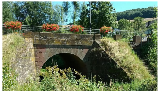
Brücke über den Weiherbach
